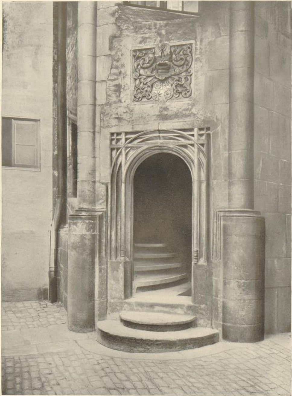
171. Schloß Detmold. Tür am linken Treppenturm im Hof.
