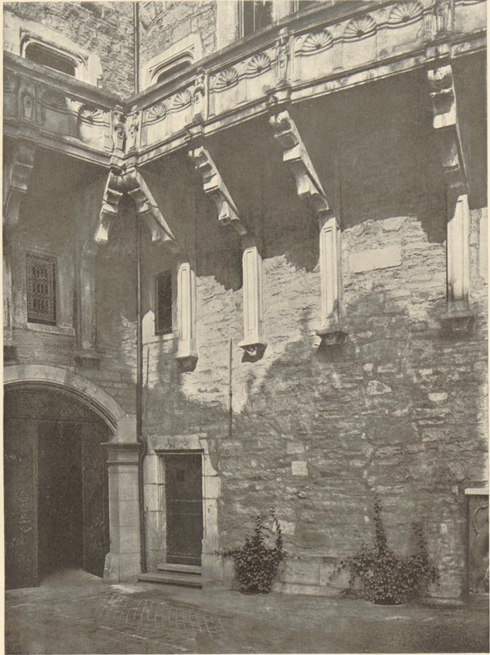
83. Schloß Bückeberg. Galerie im Innenhof.
