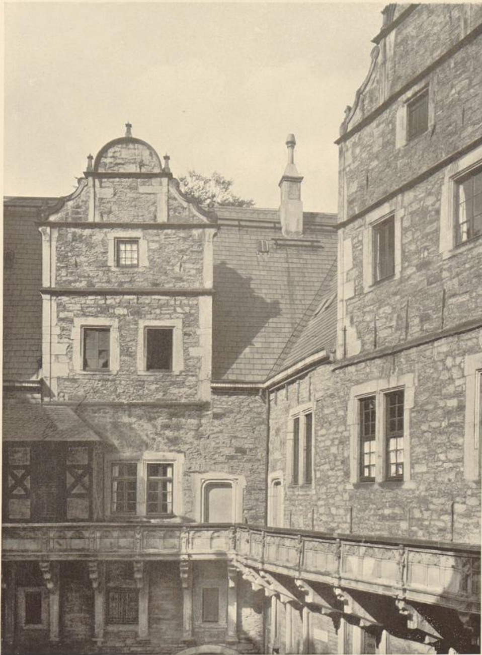
84. Schloß Bückeberg. Giebelaufbau im Innenhof.
