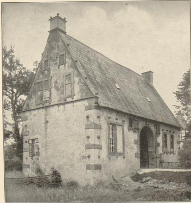
24. Torhaus der Wehrburg.
