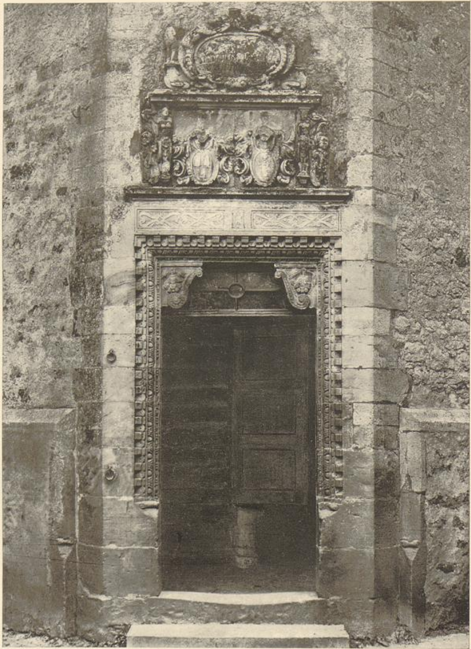
117. Rittergut Haddenhausen. Tür am Treppenturm.
