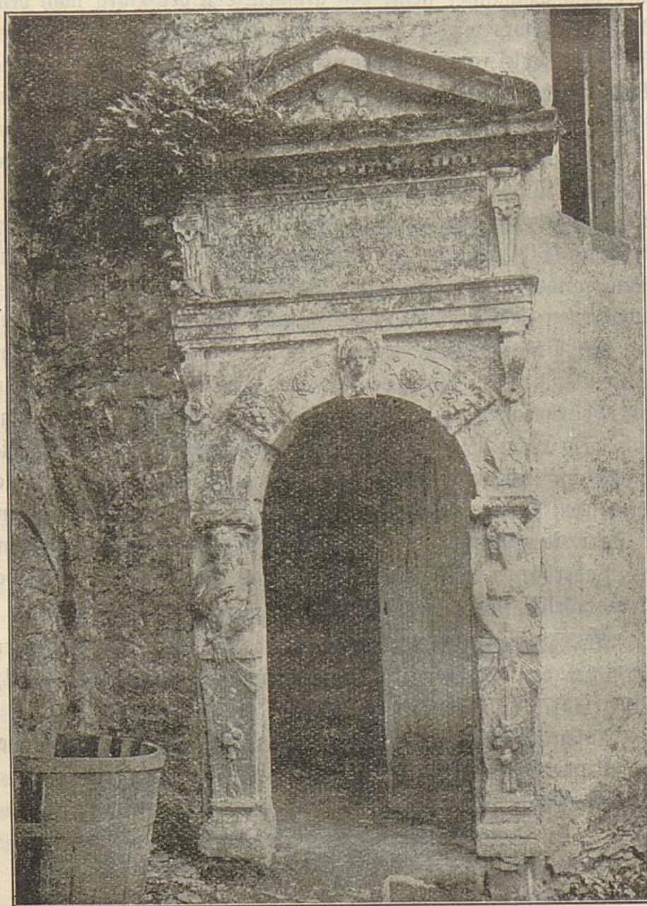
Portal des Treppenturmes.
