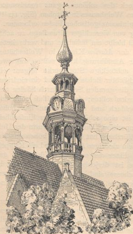
Dachreiter der Kirche des Beguinenhofes zu Gent 197) .
