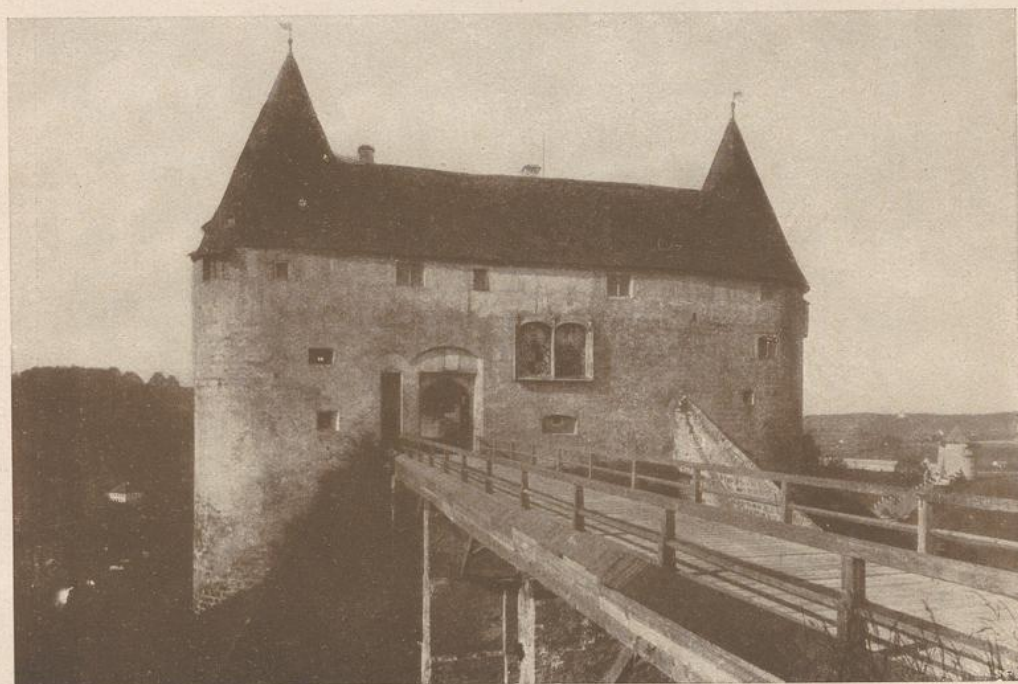
69. Burghausen: Georgstor auf der Burg, Oberbayern — Burghausen: Georges-tower at the castle
