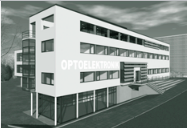
Oben: Das neue Gebäude für „Optoelektronik und Integrierte Optik“
