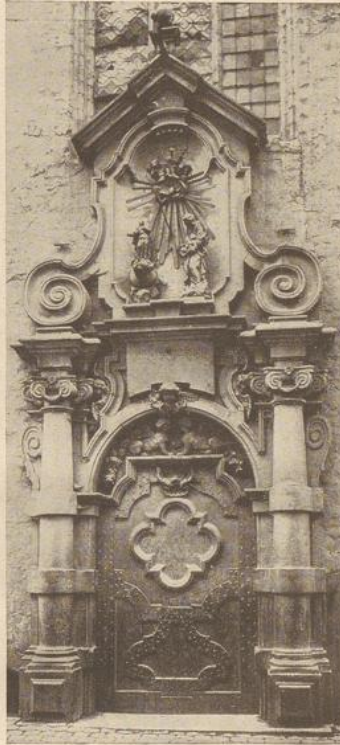
Annen-Kapelle, Portal – Porte de la Chapelle Ste. Anne
