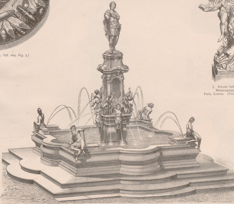
2. Der Augustusbrunnen in Augsburg, errichtet von Hubert Gerhard (1594).
