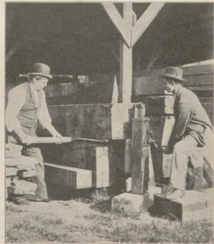
Winde. Wagenwinde, hier zum Heben von Blöcken verwendet.
