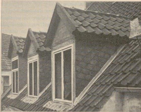
*Windfeder. Die Dachdeckung jeder der drei Lucarnen wird an den Giebelkanten durch Windfedern vor dem Abheben durch Wind geschützt.*
