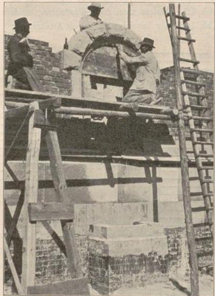
Abb. 23. Wölben. Ausführung eines Rundbogens in Bossenquadern über einem Lehrbogen.
