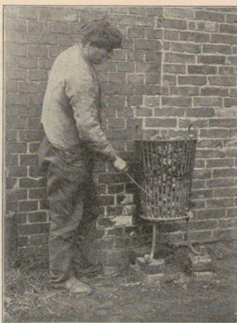
Abb. 2. Putz. Der gewöhnliche Kokskorb zum Trocknen des Mauerwerks und des Putzes, wobei Lüftung des Raumes erforderlich ist.
