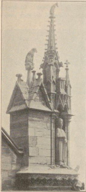
Abb. 1. Fiale. Frühgothische Strebepfeilerbekrönung am Straßburger Münster; vorn zu Heiligenhäuschen ausgestaltet, mit reicher Bekrönung aus einer Fiale inmitten und vier kleineren Eckfialen bestehend; zwischen letzteren auf drei Seiten Baldachine über Heiligenstatuen; hinten einfacher gestaltete Fiale ohne Riesen, an dessen Stelle auf Knauf eine hockende Löwenfigur, ähnlich der sitzenden Figur eines Fabelthiers auf der Spitze des Riesen der Mittelfiale. Die kleinen Eckfialen endigen in Kreuzblumen.
