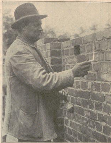
Abb. 9. Fuge. Das Ausfugen, wie es mit der gewöhnlich verwendeten Fugenkelle geschieht. Der Maurer hält in der Linken die Mauerkelle mit Fugenmörtel, von dem er mittels der Fugenkelle die Speise nach Bedürfnis wegnimmt und in die zuvor ausgekratzten Fugen einstreicht.
