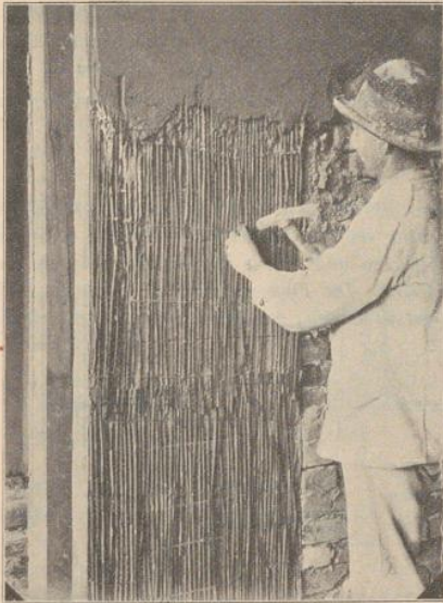
Abb. 2. Berohren. Eine (doppelte) Bretterwand (für eine Schiebethür) ist mit Rohrgewebe benagelt und bereits oben geputzt.
