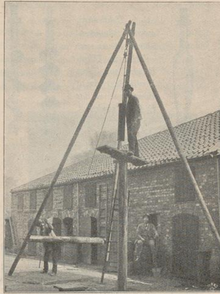
Abb. 8. Baugrund. Der gefüllte Bohrer soll entleert werden; er wird von dem unten stehenden Arbeiter mittels einer an dem Bockgerüste befestigten Welle hoch gewunden.
