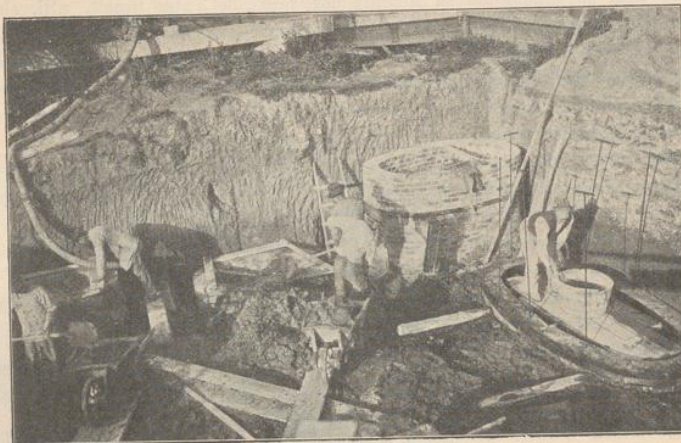
Brunnen, aus Backstein gemauerte Senkbrunnen zur Gründung eines Gebäudes. Man sieht die vom Brunnenkranze aufragenden eisernen Anker zur Versteifung des Mauerwerks und das ebenfalls dazu dienende eiserne Band. Die Senkung geschieht durch Graben und, wenn das Grundwasser hinderlich wird, durch Baggern.
