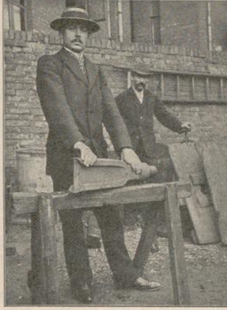
Abb. 21. Bohrer für felsigen Boden. Daxu werden auch Meißelbohrer, Abb. 12, verwendet. Sie wirken stoßweise auf das Gestein. Bei jedem Stoße wird der Bohrer gedreht. Die gelöste Masse wird durch Löffelbohrer nach oben befördert.
