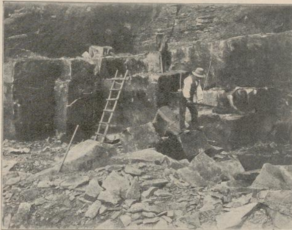
Baustein. Das Loslösen der Bausteine im Bruche.
