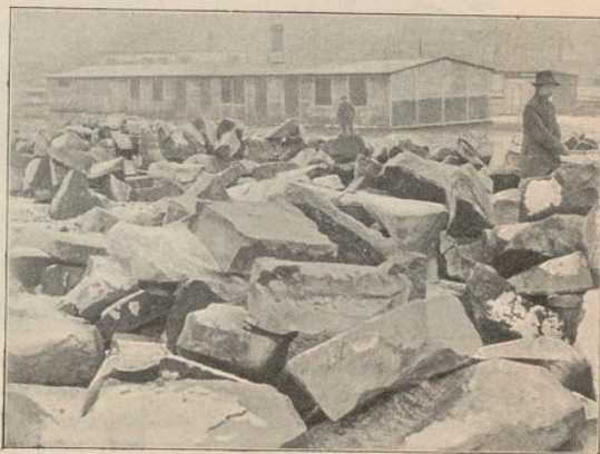
Bruchsteine, wie sie auf dem Bauplatze angefahren sind.
