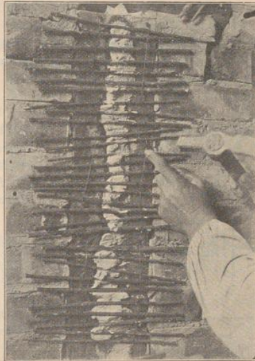
Abb. 3. Das Berohren der Stiele einer Fachwand, wobei, um das Reißen des Putzes zu verhindern, die Rohrstengel bis 10 cm auf die Ausmauerung übergreifen. Die Stengel sind in Weißkalk eingedrückt, damit sie sich bis zur Befestigung durch den Draht halten.
