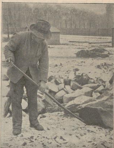
Brecheisen zum Heben und Kanten gröfserer Steine.
