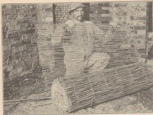
Abb. 1. Berohren. Eine Rolle Rohrgewebe hier 1,40 m lang; sonst in Längen von 1,0 bis 2,0 m gebräuchlich.
