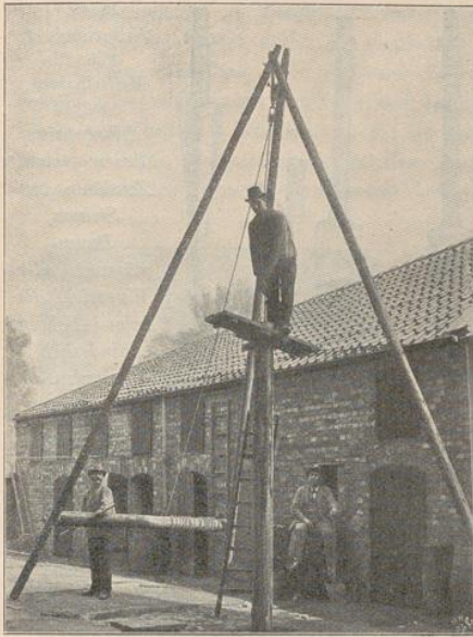
Abb. 4. Baugrund. Das Bohren mit dem Ventilbohrer, der sich in einem Mantel- oder Futterrohre bewegt. Der von dem Arbeiter gehobene Bohrer fällt nieder und füllt sich. Statt des eisernen Gestänges bei der frei fallenden Bewegung ein Seil. Dieses läuft über eine an dem dreibeinigen Bockgerüst befestigte Rolle und dient zum Herausheben des Bohrers. Das Futterrohr sinkt durch das Gewicht des auf ihm stehenden Arbeiters, dem Eindringen des Bohrers folgend, in den Boden und verhütet das Einstürzen der Bohrlöchwandung. Das Sinken wird gefördert durch Drehen des Rohres mittels des Wendeeisens während des Bohrens oder mittels der hölzernen Klemme, auf der der Arbeiter steht, oder durch weitere Belastung der Klemme mit schweren Gegenständen, Steinen oder Eisen. Einrammen der Futterrohre wegen der dünnen Wandung unmöglich.
