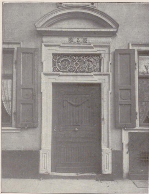
Abb. 276. Tür aus Heidelberg.
