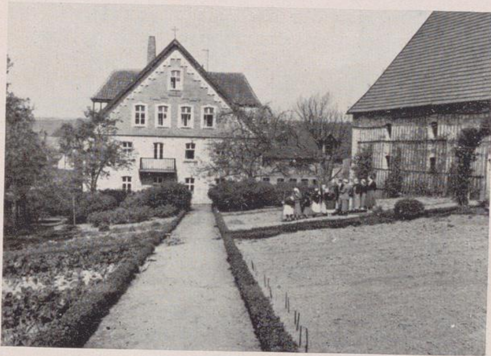
Schulhaus (Matthiges), Ansicht von Südosten
