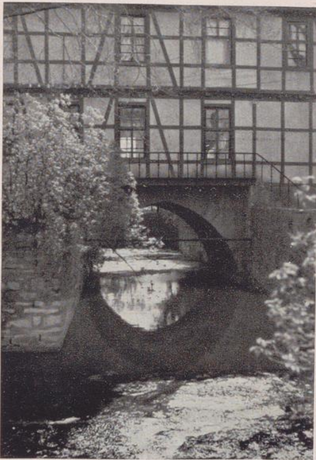
Erweiterung des Oberhauses, Ueberbrückung der Gräfte
