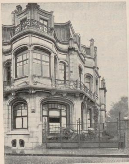
570. — Viktor Horta, Fassade des Hauses Aubecq (Brüssel).
