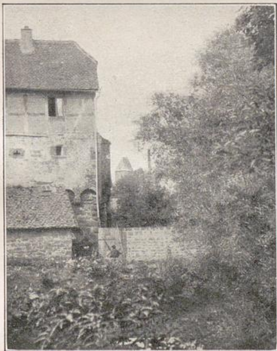
4. Haus auf einem alten Mauerrest in Gelnhausen.
