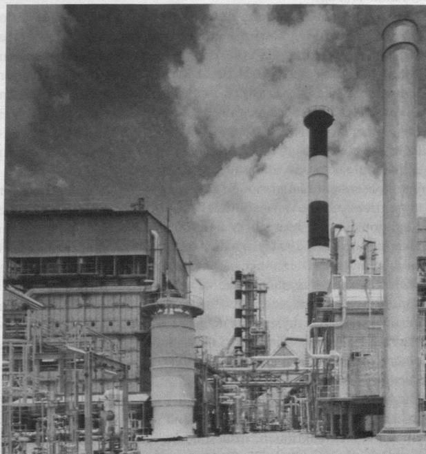
Abb. 1. Ammoniak-Anlage mit optimierter Wärmenutzung (Uhde GmbH, Dortmund).
