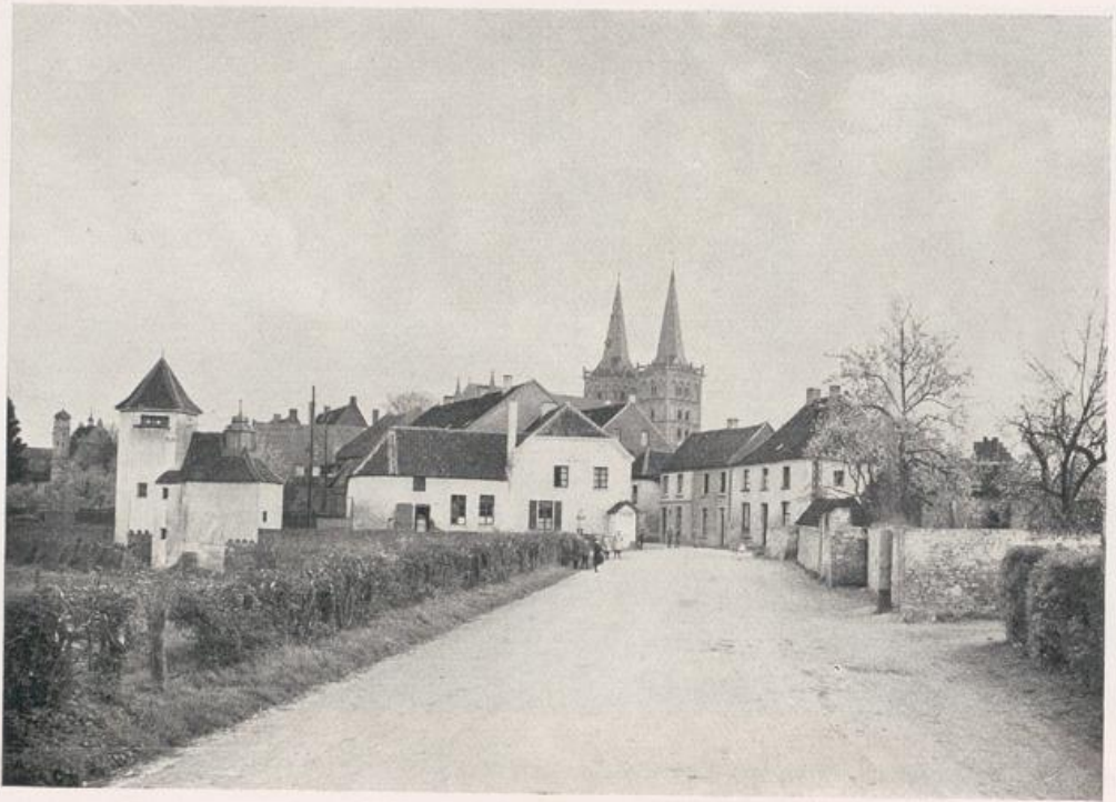
Xanten. Ansicht von Nordosten.
