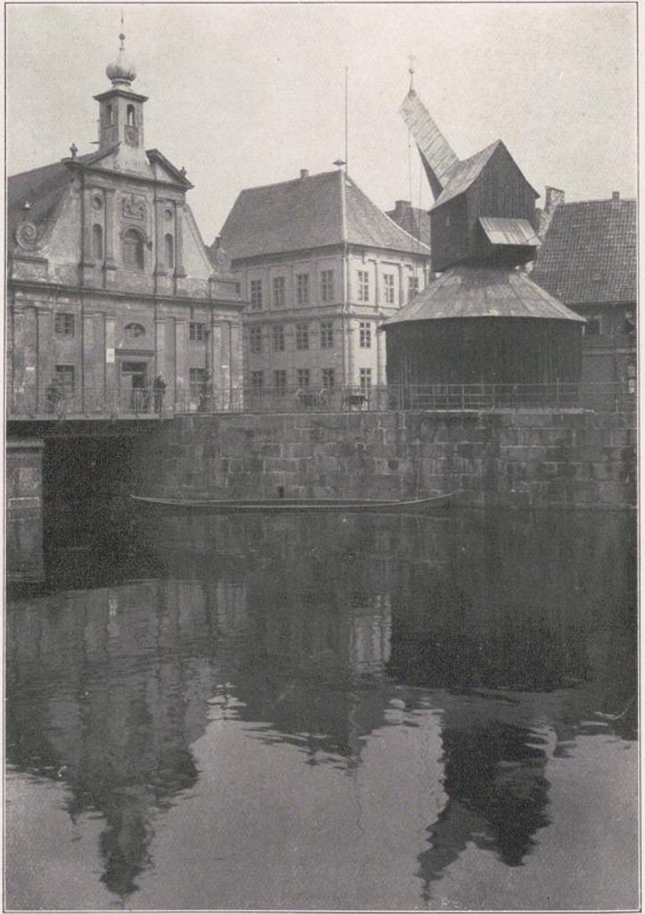
105. Lüneburg: Krahn und Kaufhaus an der Ilmenau
