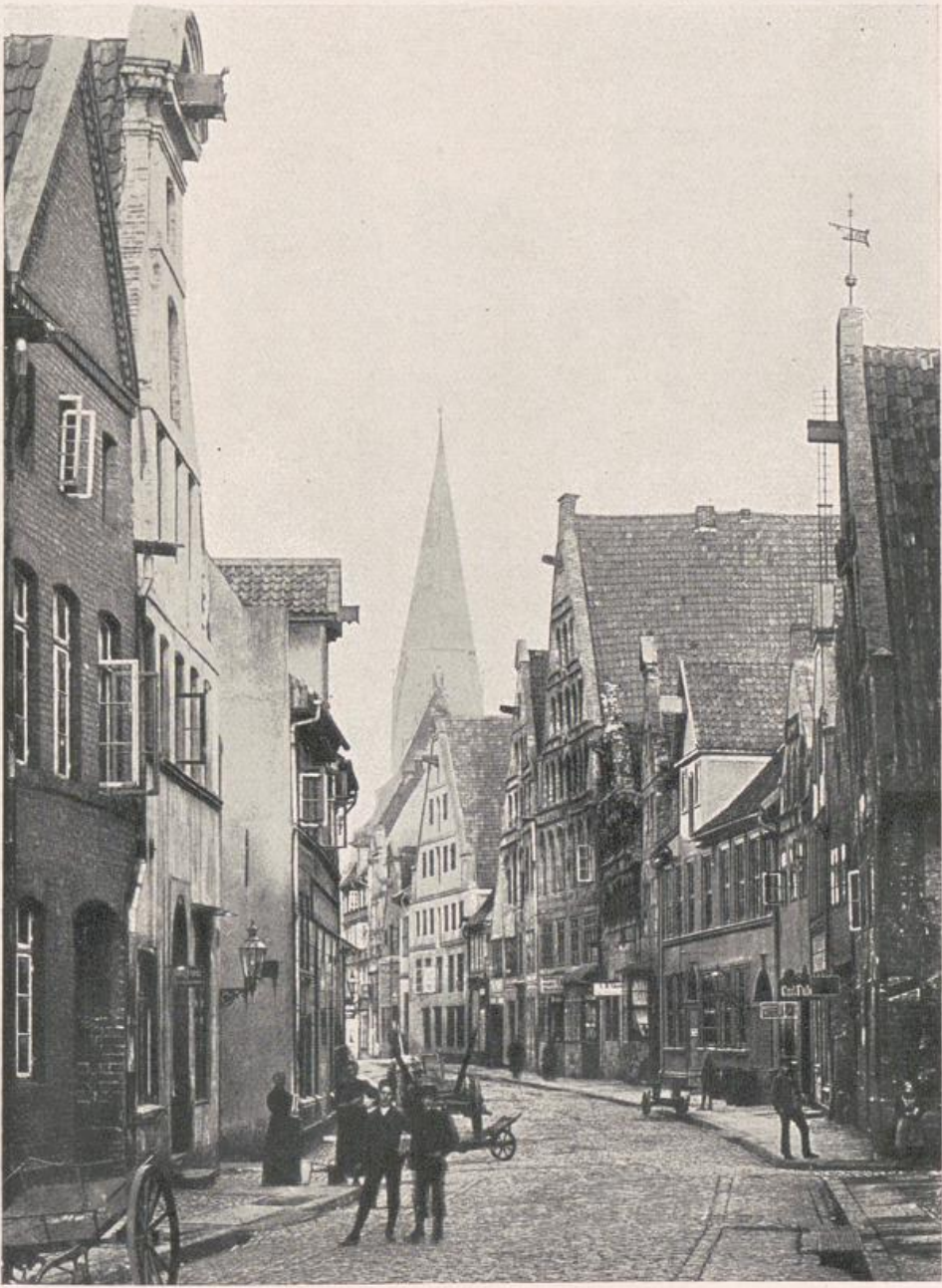
72. Lüneburg: Wandfärberstraße, mit alten Ziegelbauten
