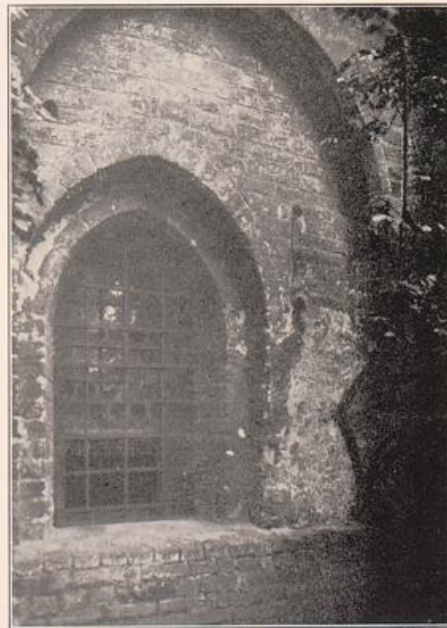
d. Kryptafenster mit romanischem Mauerrest rechts.
