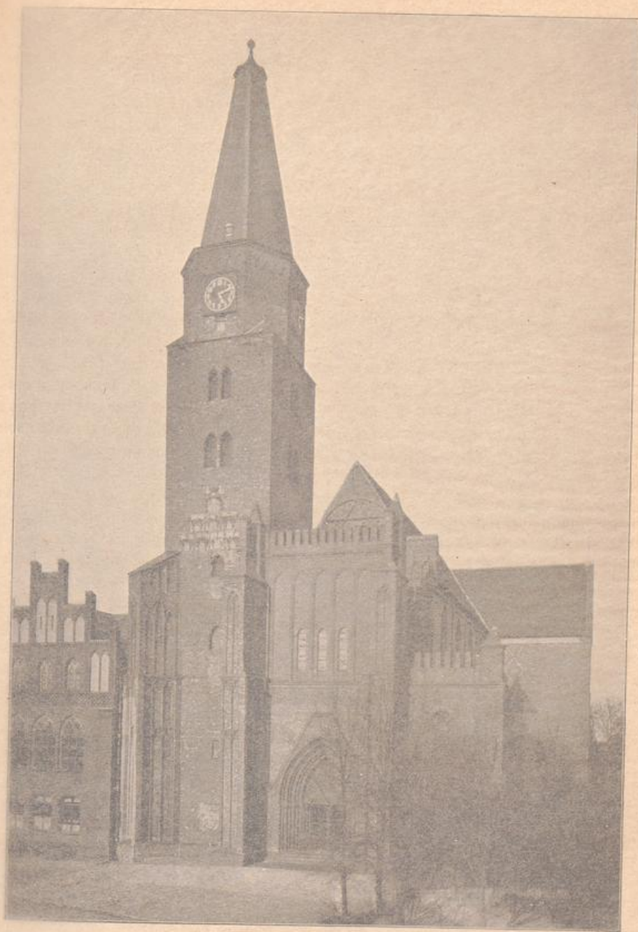
Domkirche von Südwesten.
