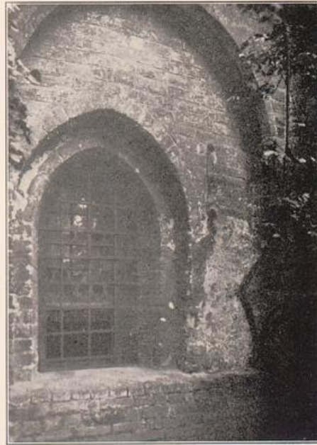
d. Kryptafenster mit romanischem Mauerrest rechts.
