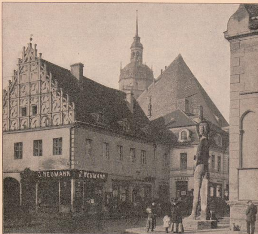
Abb. 113. Ehemaliges Haus Storbeck (Ecke Haupt- und Steinstraße).
