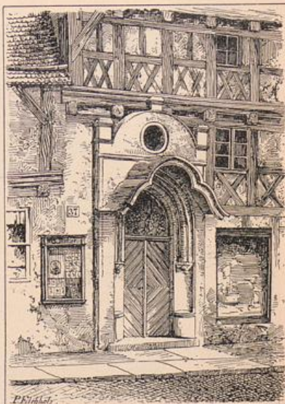
Abb. 112. Portal des ehemaligen Abts-hauses.
