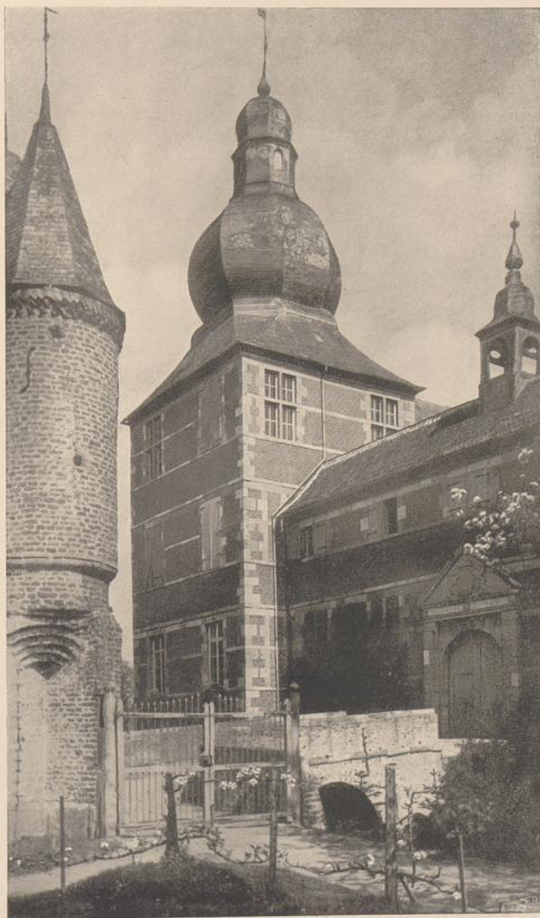
Abb. 297. Schloß Leerodt. Einfahrt in das Herrenhaus. Vgl. Abb. 290, 291.
