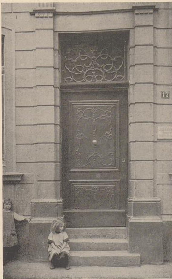
Abb. 212. Düsseldorf. Zitadellstraße Nr. 17 (Haus Pfeilsticker).
