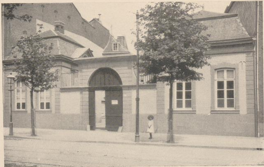
Abb 107. Aachen. Vorgebäude vom Hause Fey im Seilgraben. Vgl. Abb. 108
