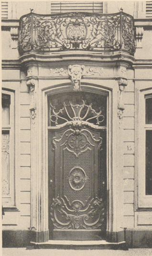
Abb. 83. Aachen. Haus Wespian. Haustür. Vgl. Abb. 84.
