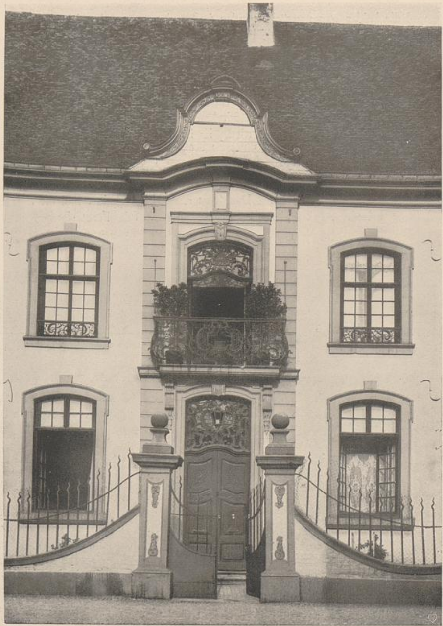
Abb. 173. Heinsberg. Mittelstück des ehemaligen Prämonstratenserklosters. Vgl. Abb. 172.
