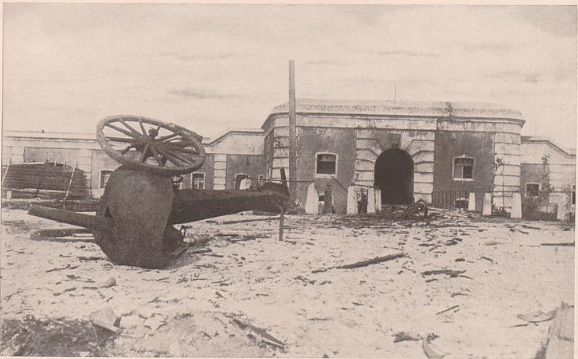
Nr. 93. Das Fort Erbraudt. Die vorn sichtbare belgische Kanone wurde durch den furchtbaren Luftdruck beim Bombardement über die Schelde auf eine Straße geworfen, wo sie liegen blieb
