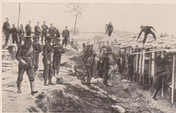
Nr. 149. Englische Truppen beim Bau einer Verteidigungsstellung
