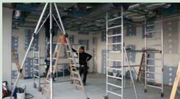
Bau des neuen experimentierauglichen Seminarraums mit angeschlossener Laborfläche
