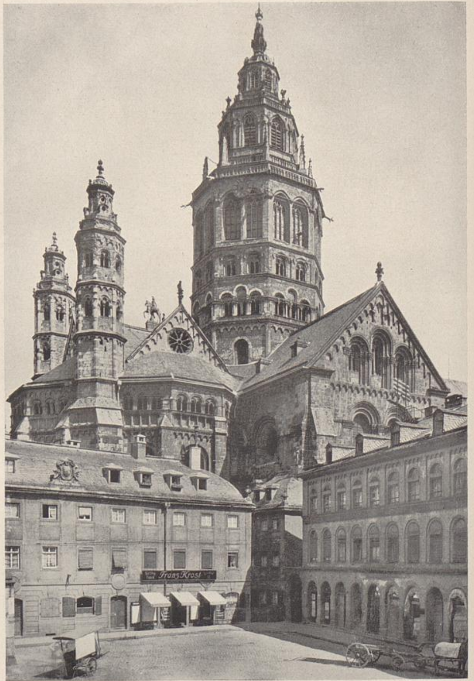
43. Mainz, Dom von Südwesten
