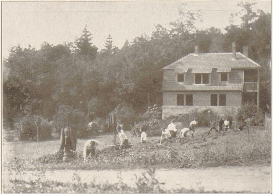
Bau der Wasserleitung für Haus Emilia
