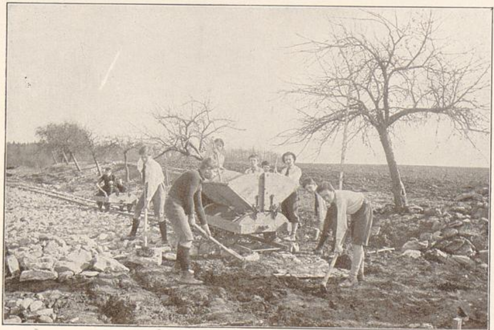
Bei der Erdarbeit
