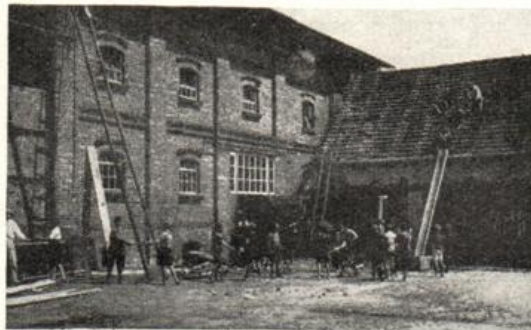
Schullandheim Zerpenschleuse: Schulkinder einer Volksschule helfen beim Ausbau.
