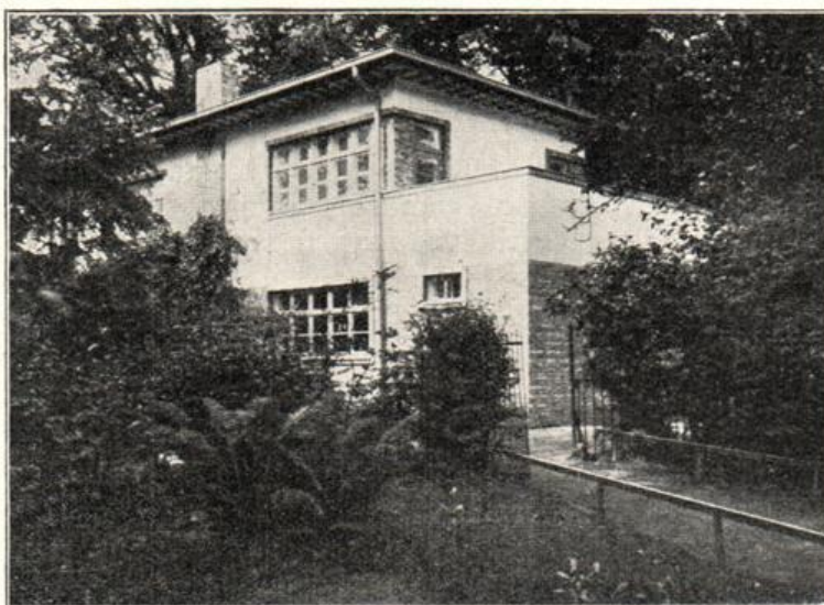
Werkstättenhaus mit Feuerweherschuppen.
