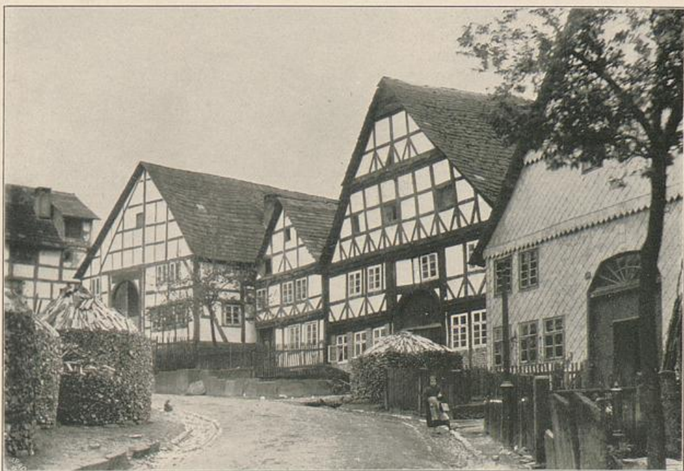
Abb. 62. Straße in Echershausen.
